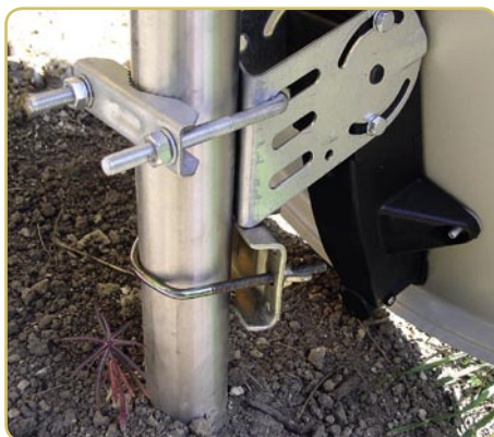
Допълнителни монтажни скоби за стабилизиране на антената по време на нейната настройка
