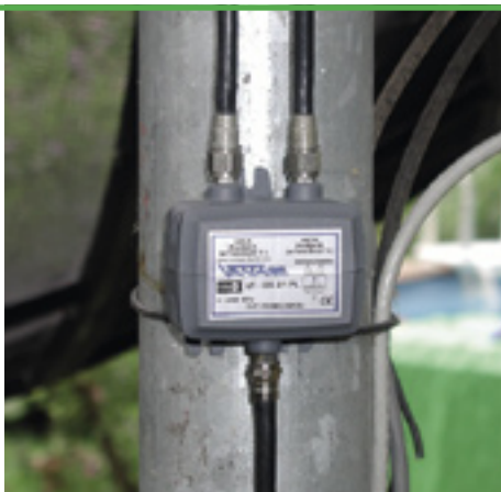
DS 2/1 PL commutateur branché aux LNB de bande C et Ku d'une parabole de 10 pieds
