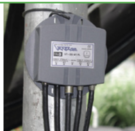
Commutateur DS 4/1 PL branché à la même parabole de 10 pieds et deux paraboles supplémentaires
