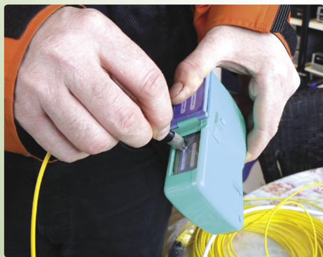
Słowo ostrzeżenie dla wszystkich instalatorów: nigdy od razu nie łączyć światłowódów – zakończenia kabli muszą być idealnie czyste zanim dojdzie do połączenia. Stosuje się w tym celu różne metody: najpraktyczniejsze jest wykorzystanie pokazanego na zdjęciu urządzenia. Końcówkę światłowodu wprowadza się do wnętrza, a następnie naciska się dźwignię, która powoduje przetarcie końcówki drobnonaziarnistym papierem ściernym, który używany jest tylko jednokrotnie. Tylko tak można zapewnić połączenie, które nie wprowadzi dodatkowego tłumienia.
