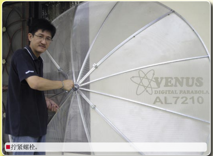
■ 安装完毕! 所有面板都已相互衔接妥当并在背面固定好。
