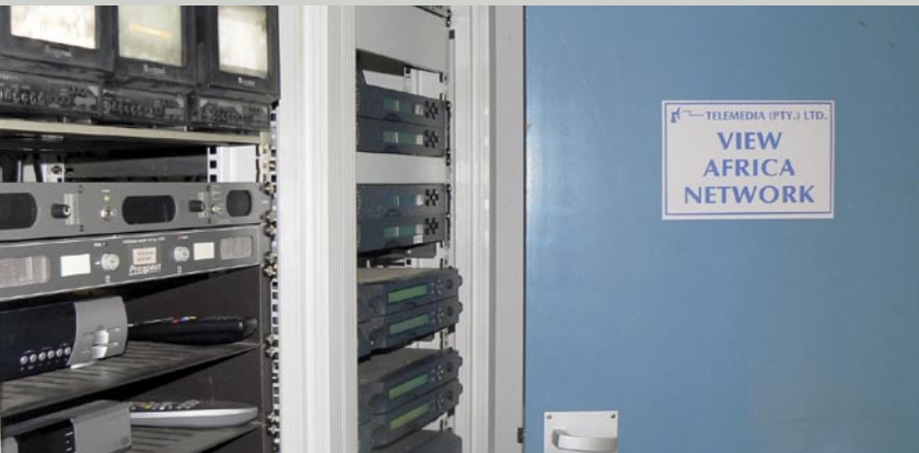
▲这里是《观察非洲》频道套餐的核心：在左边可以看见机柜里的监视器和接收机，右边是各种频道的编码器，而频道编播室就距此只有一步之遥。
