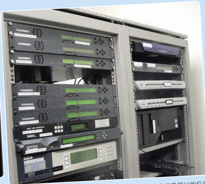
在这里处理信号，泰德接口是留给操作卫星的。微波接力线路接口的信号来自南非卫星服务供应商—森泰克。
