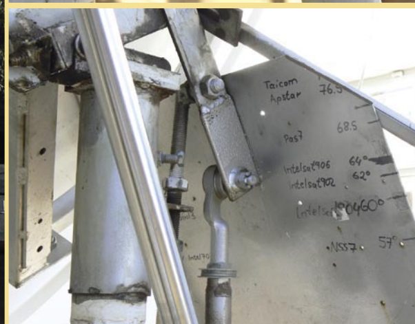
当转动天线位置时定位标记是完全必要的，这个金属板上标记了好多位置 ▲ 的记号。
