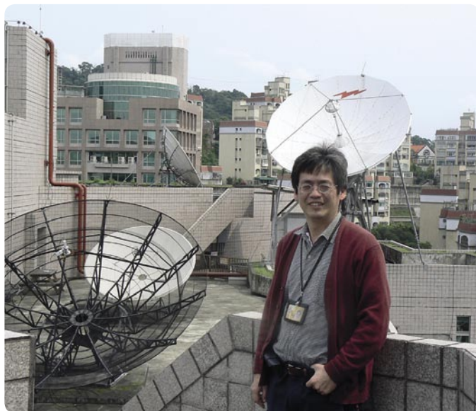
▲ 陈凯文是工程部经理,他解释着公视大楼楼顶每个天线的功能。背景里巨大的抛物面天线直径为5.6米,它将公视频道上行传送给位于88° E的ST-1卫星。左侧两个天线尺寸为5米和3米,它们都是对着ASIASAT 卫星。为什么两个天线对着同一个卫星呢?陈凯文解释说:当英国广播公司的2000 Millenium 24 小时庆祝活动对全球直播时,公视也参加了。竖起第二个天线是为防止出现意外而做的备份。
