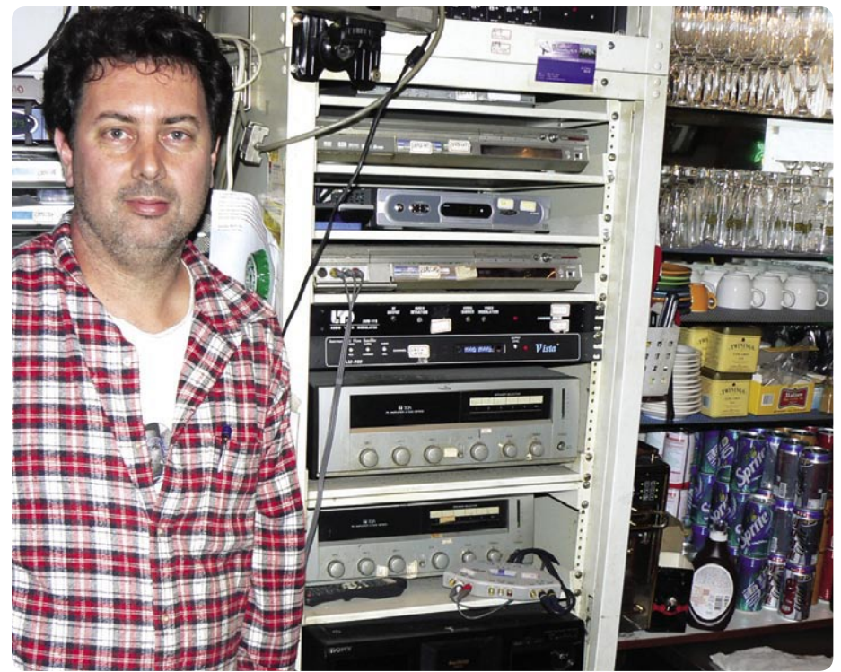
▲ 吉姆·埃德斯坦站在装满卫星接收机(从上到下)的机柜和音频放大机之前。信号通过 PVR,这样使短暂的停顿被跳过。吉姆解释说:“从楼顶来的信号要走过将近 200 米的距离,我决定使用 RG11 电缆。”为了这项卫星安装工程,他大约用了 3 公里的同轴电缆。
