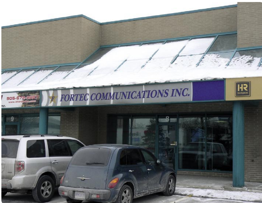
第 8 单元是天际大街2780号长长的商业建筑的一部分，它与东西走向的主街艾哥林顿大街平行，Fortec Star 的办公室就在这里。商店则位于一个提供综合服务的复杂综合性建筑物内。
