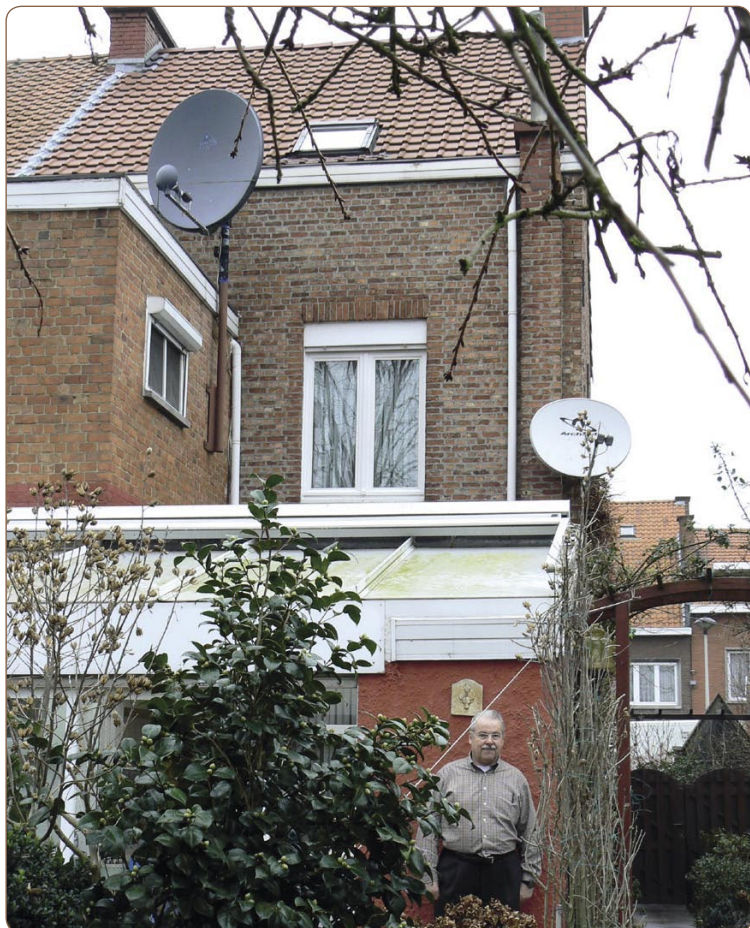
1.2米的电动天线隐藏在左上方的树枝后面。另一个多馈源天线固定在外墙上用于接收标准频道。雷欧·斯窦腾站在他的花园里。
