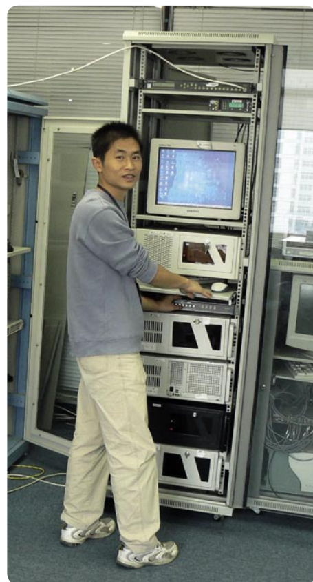
正在进行模块性能检验
