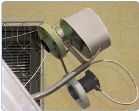
一个简单的办法：用一个金属杆将第二个馈源连接到主馈源上
