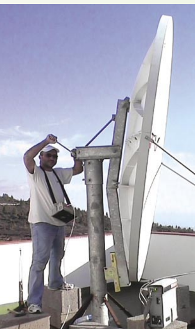
■ La petite élévation nécessaire pour recevoir les satellites américains frappe tout de suite. Car l'emplacement de Diego est assez haut dans les montagnes il peut assurer la réception même avec une si basse élévation.
