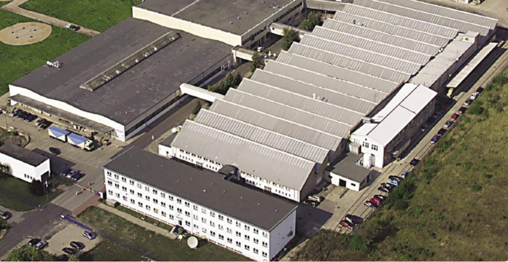
▲ Vue aérienne de TechniSat : Les entrepôts se situent à gauche, le bâtiment administratif vers l'avant et les installations de production à l'arrière.
