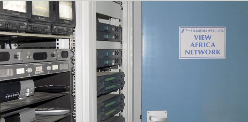
▲ Voici le cœur du bouquet des chaînes View Africa : Les écrans de réception et les récepteurs sont installés dans l'armoire de gauche alors que celle de droite abrite les diverses platines d'encodage pour les différentes chaînes. Les Feeds d'un grand nombre de ces chaînes arrivent des studios qui ne se trouvent qu'à quelques pas d'ici.
