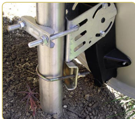
Un collier supplémentaire pour stabiliser la parabole durant le pointage
