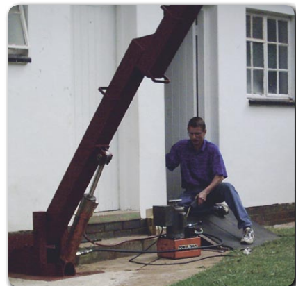
Une élévateur hydraulique emmène l'antenne à la position verticale
