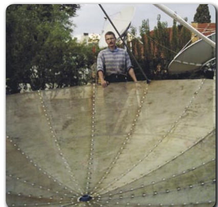
L'assemblage du réflecteur est terminé; il peut désormais être emmené à sa position définitive.
