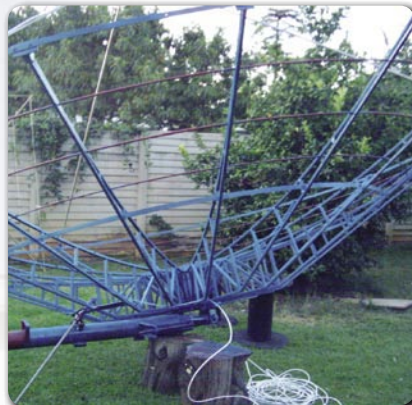
Tous les bras de support sont maintenant installés; vient ensuite l'installation des panneaux réflecteurs en aluminium
