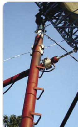
Un vérin soudé au mât pour faire pivoter l'antenne.
