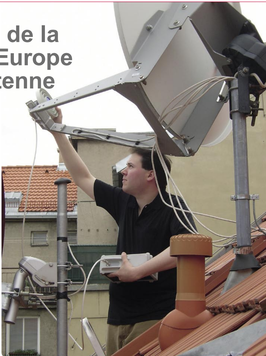
Il installe une source pour la bande C sur une antenne de 120 cm tout en vérifiant les résultats à l'aide de l'analyseur de signal Prodig-5 que nous présentons aussi dans cette édition |
