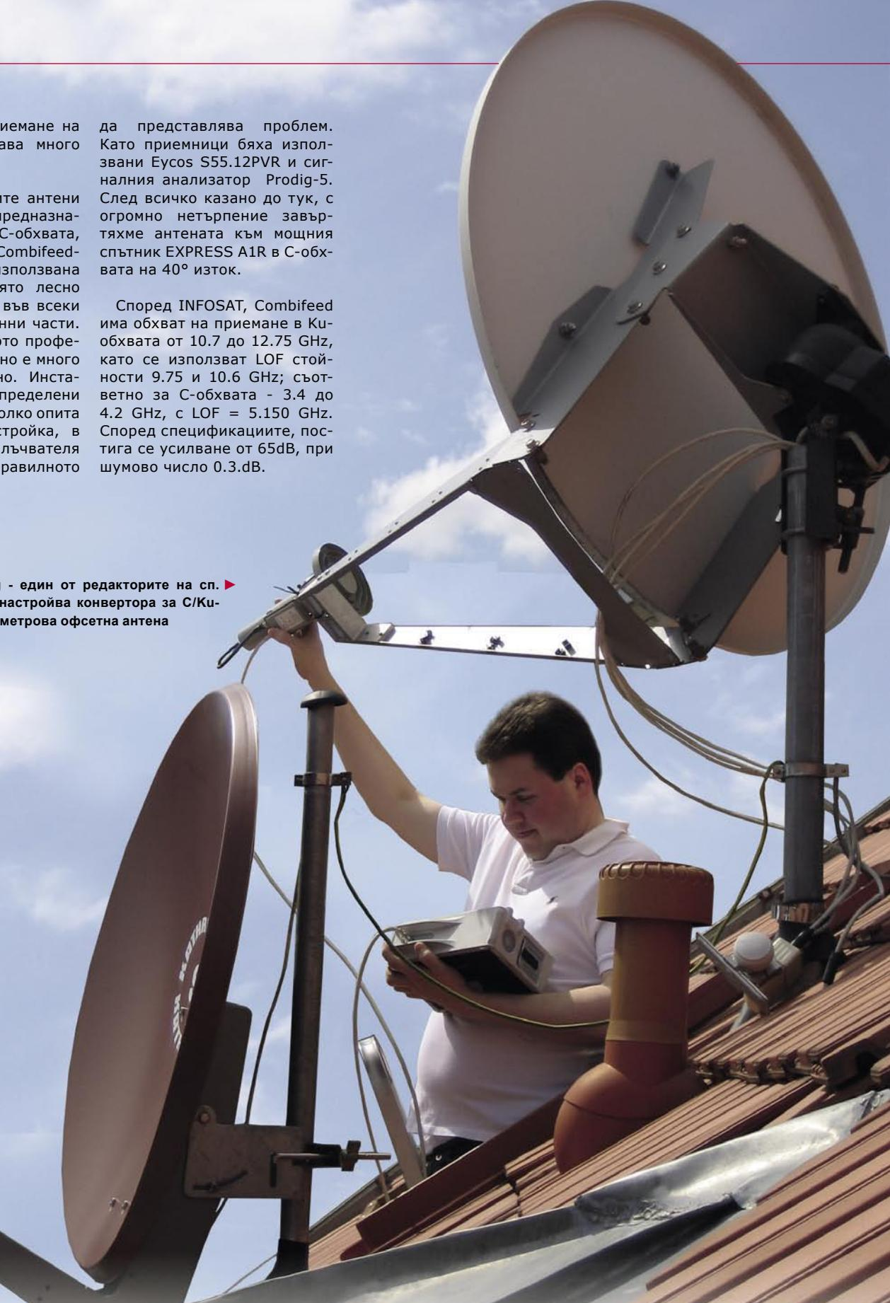
Целият монтаж, заедно с поставянето на антеннния мотор, беше предварително направен, с използване на стандартен 40 mm конвертор за Ku-обхвата и затова, приемането на по-слабо чувствителния C-обхват не трябваше
